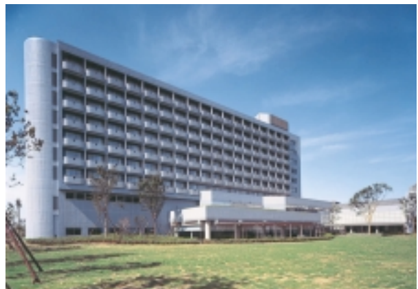
▲日本興亜総合研修センター（茨城県守谷市）
