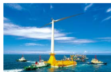
洋上風力発電施設の建設風景 (写真の出典元：ひびきフローティング ウィンドパワー合同会社)
