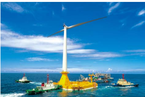
洋上風力発電施設の建設風景
