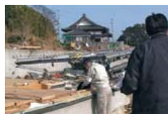
損害調査の様子
